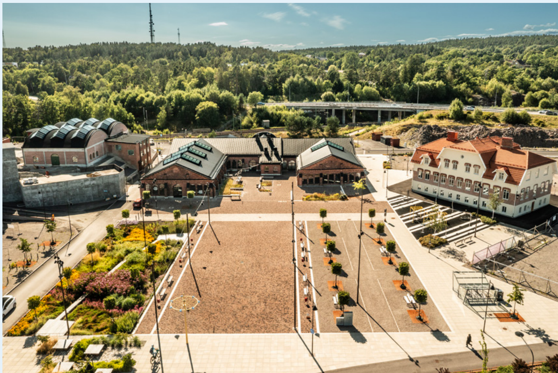
Översiktsbild över Värvik med fastigheterna Hyveljärnsfabriken, Filfabriken och Kontoret.
